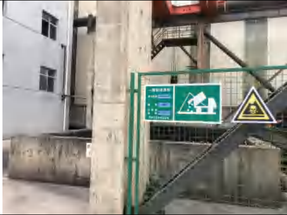
浊环水处理系统污泥暂存池
