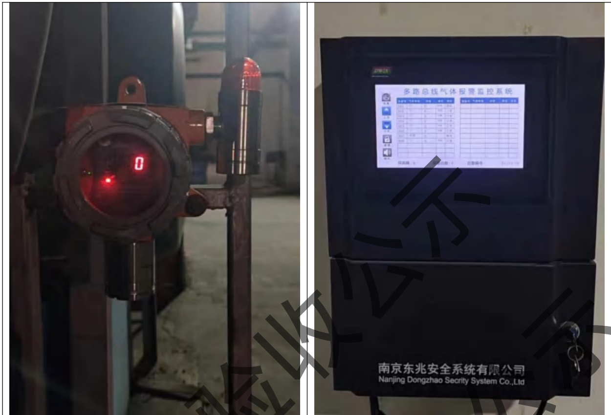
图 4.5-1 已配置在线检测报警器
