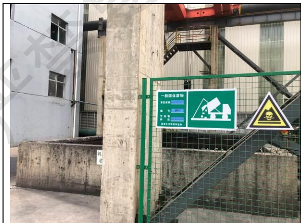
浊环水处理系统污泥暂存池
