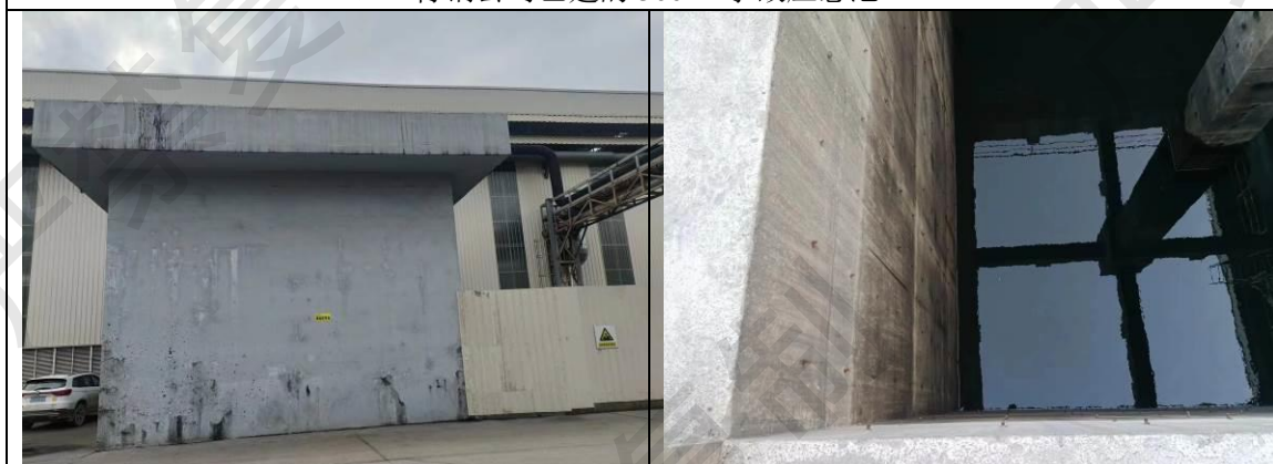
特钢公司已建的 480m 3 事故应急池
