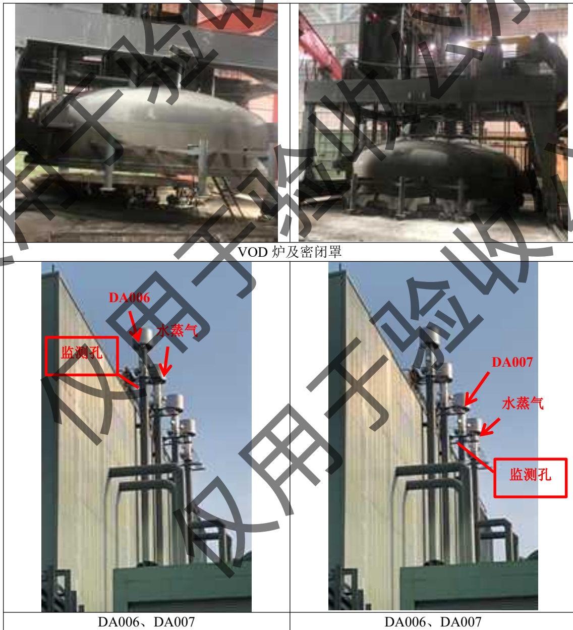
图 4.1-10 VOD 炉烟气除尘系统
