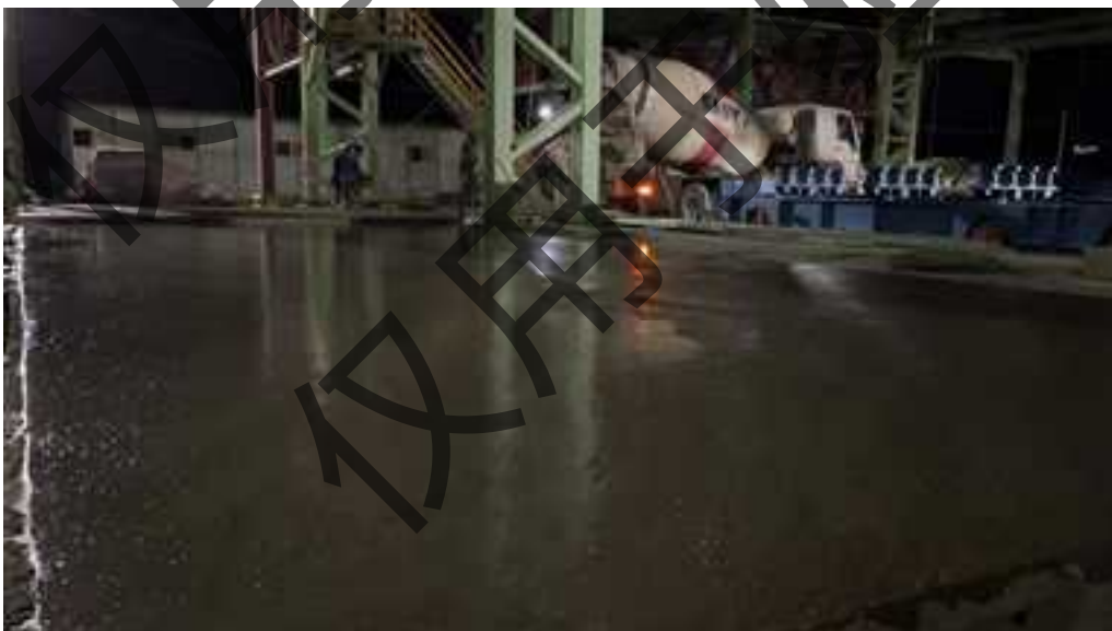
炼钢车间地面浇筑 30 公分厚度混凝土
